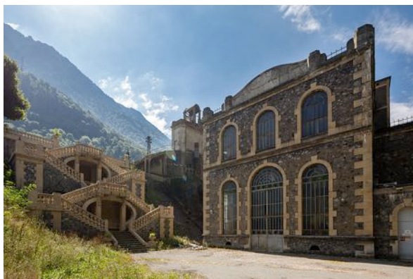
Centrale hydroélectrique des Vernes à Livet et Gavet ©EduardHue
