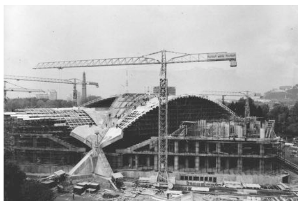
Chantier du Palais des sports © AMMG
